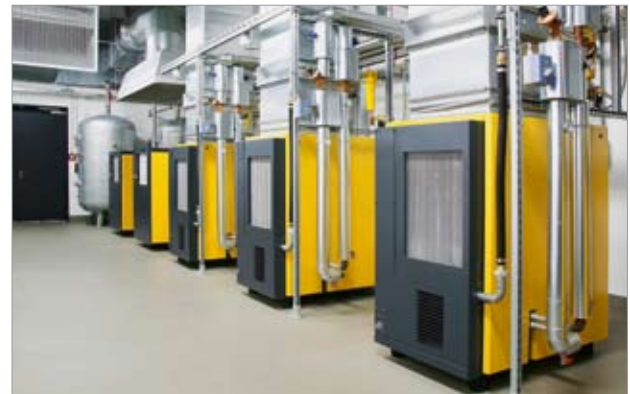
Installation von Abluftkanälen
